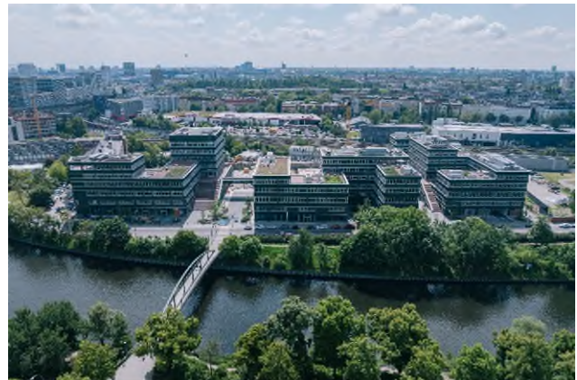
Innovationscampus BERLIN DECKS in Berlin-Mitte, Gebäude 1 & 2 rechts im Bild © BEOS AG
