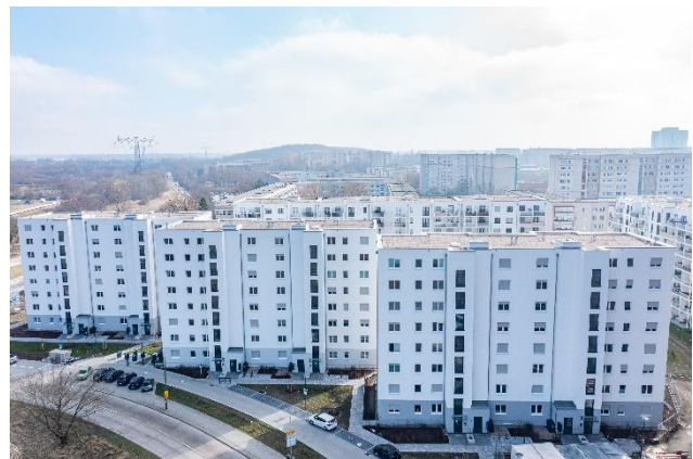
Das Neubauprojekt in Berlin ist Teil des Portfolios „Terra City“ © freedimensions
