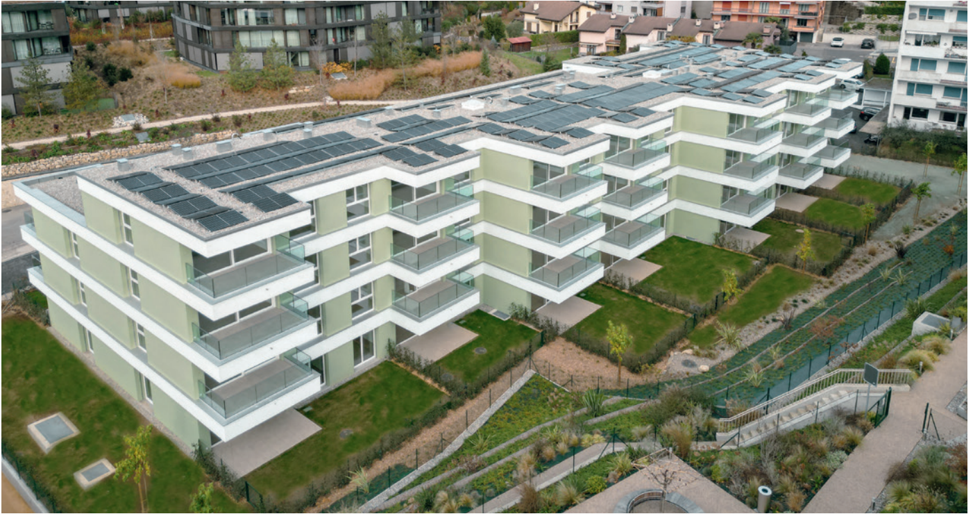
Installation solaire sur le toit, pompe à chaleur à la cave: ce projet résidentiel mise sur la durabilité. Source: Artisa
