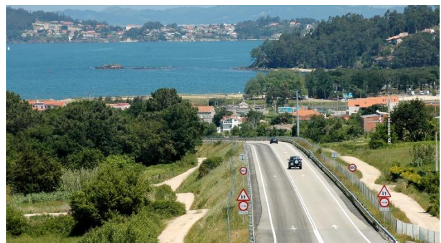
Autoroute AG-57. Puxeiros, Val Miñor (source : Itínere Infraestructuras )
