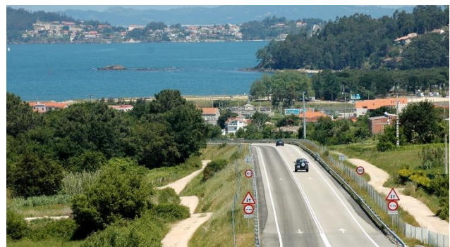
Motorway AG-57. Puxeiros, Val Miñor (source: Itinere Infraestructuras)
