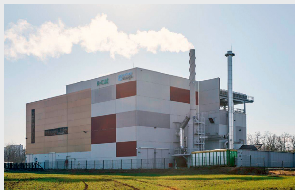
Centrale thermique de Primeo Energie et R-CUE. Source : Primeo Energie
