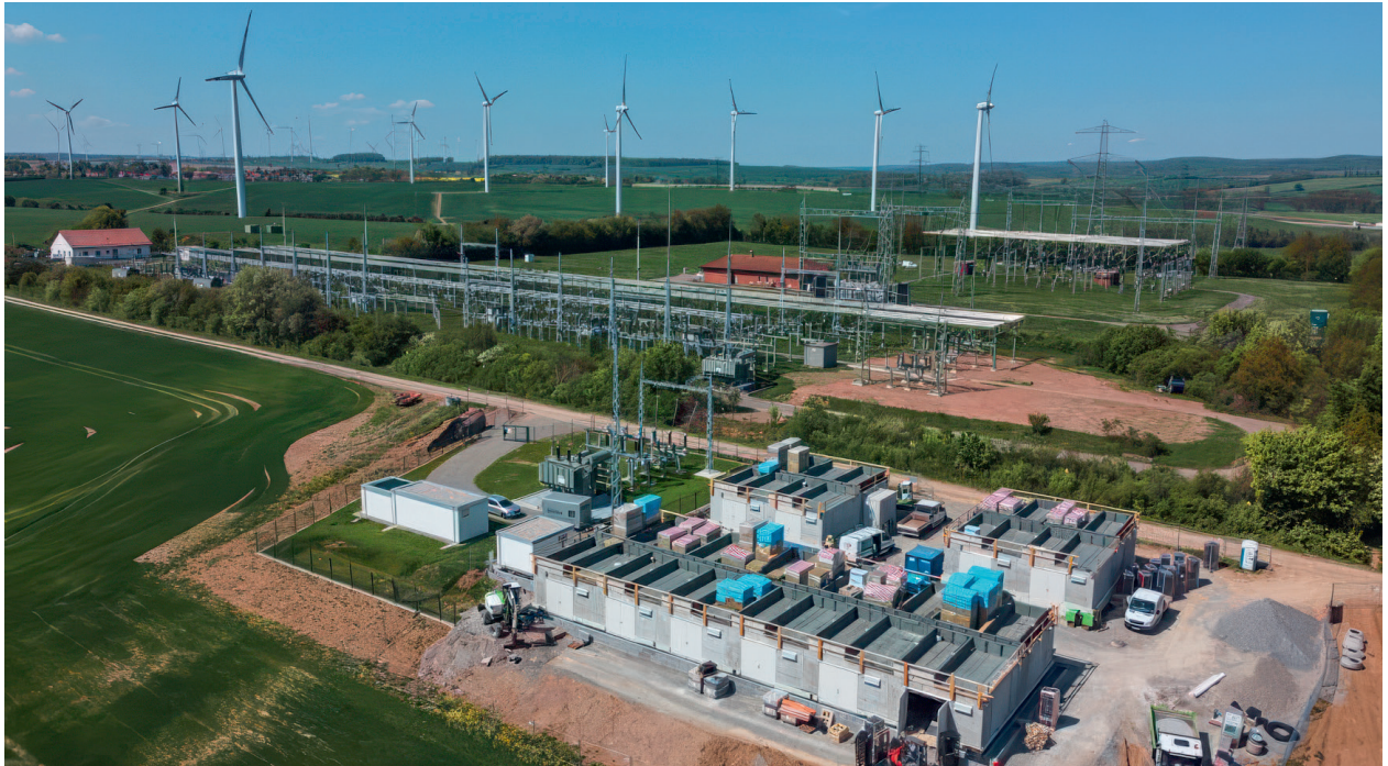
Projekt Smareg 4 in Eisenach, Deutschland. Quelle: Smart Power
