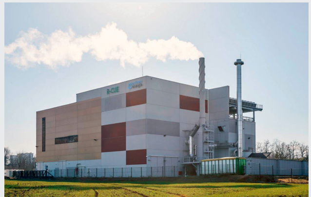
Wärmekraftwerk von Primeo Energie und R-CUE. Quelle: Primeo Energie
