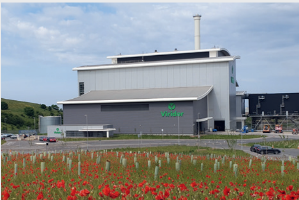
Installation de récupération d'énergie de Viridor, Dunbar. Source: Viridor
