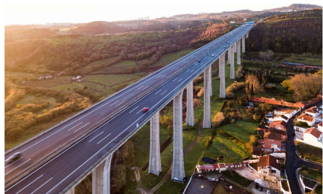
Brisa Concessão Rodoviária's viaduct
