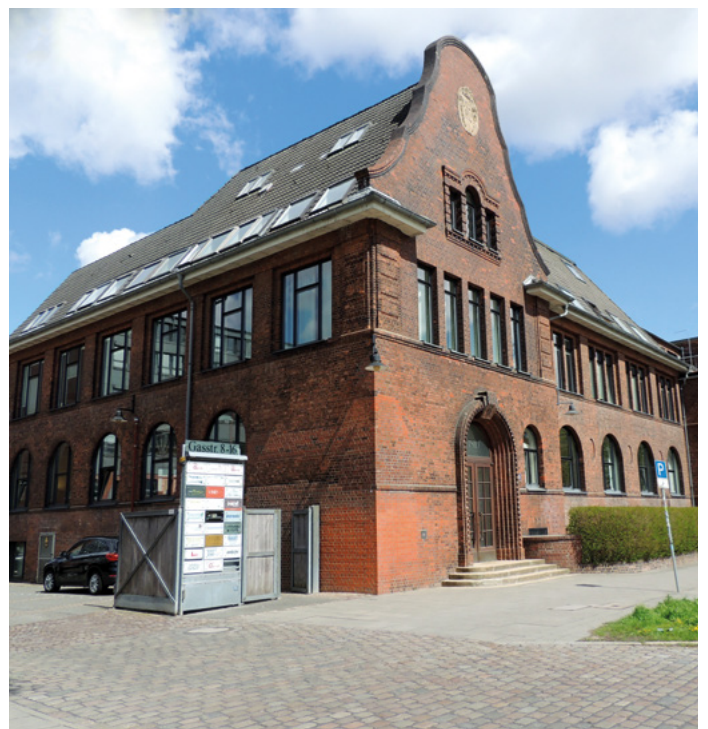
La zone industrielle rénovée « Conz Höfe » de Hambourg, détenue par Swiss Life
