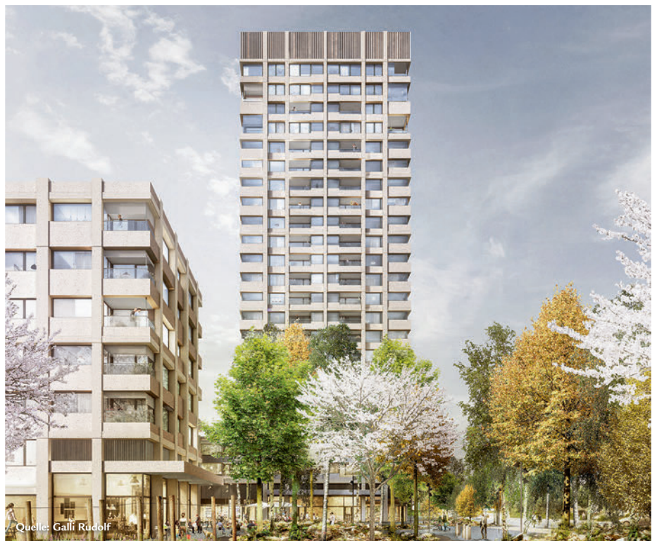
Quelle: Galli Rudolf Neue Massstäbe in der Stadtentwicklung: Das neu errichtete Wohnhochhaus in Zürich Altstetten.
