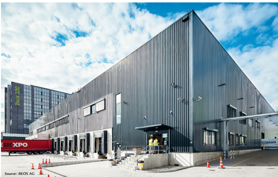
Dans ce que l'on appelle le « Dock100 », BEOS AG a conçu un centre de distribution de quelque 13 700 mètres carrés, à partir duquel les quartiers centraux de Berlin sont approvisionnés en l'espace d'une heure.
