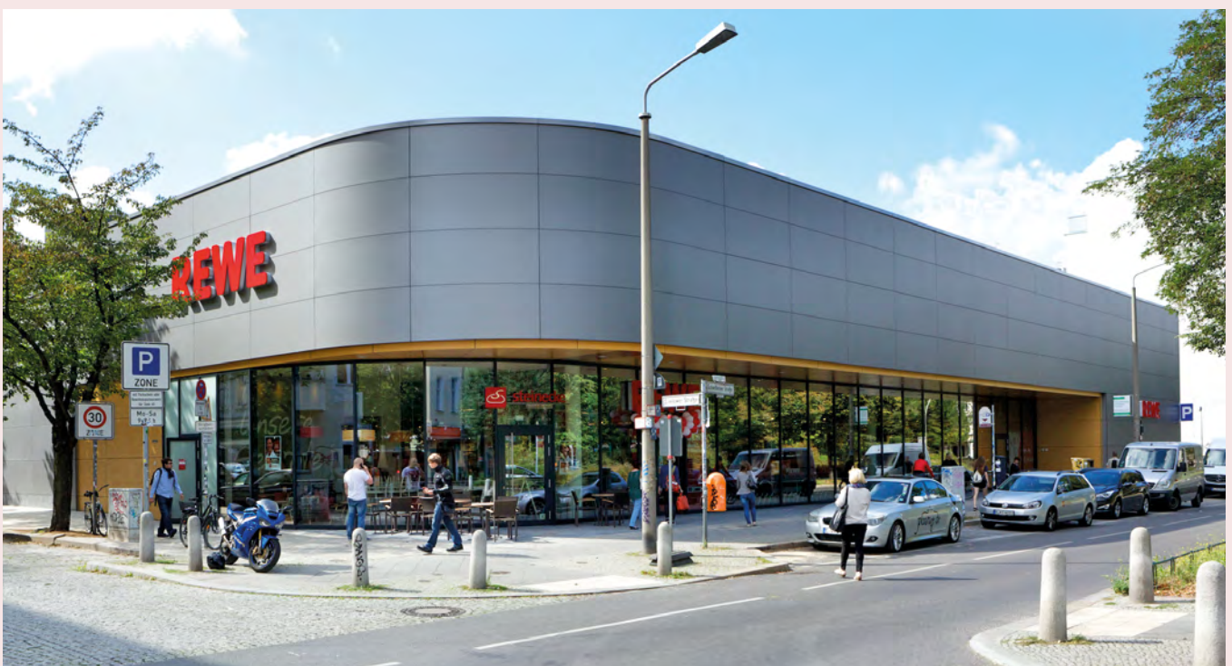
REWE-Supermarkt an der Berliner Schivelbeiner Strasse (Quelle: Architekten Kühnl + Schmidt)
