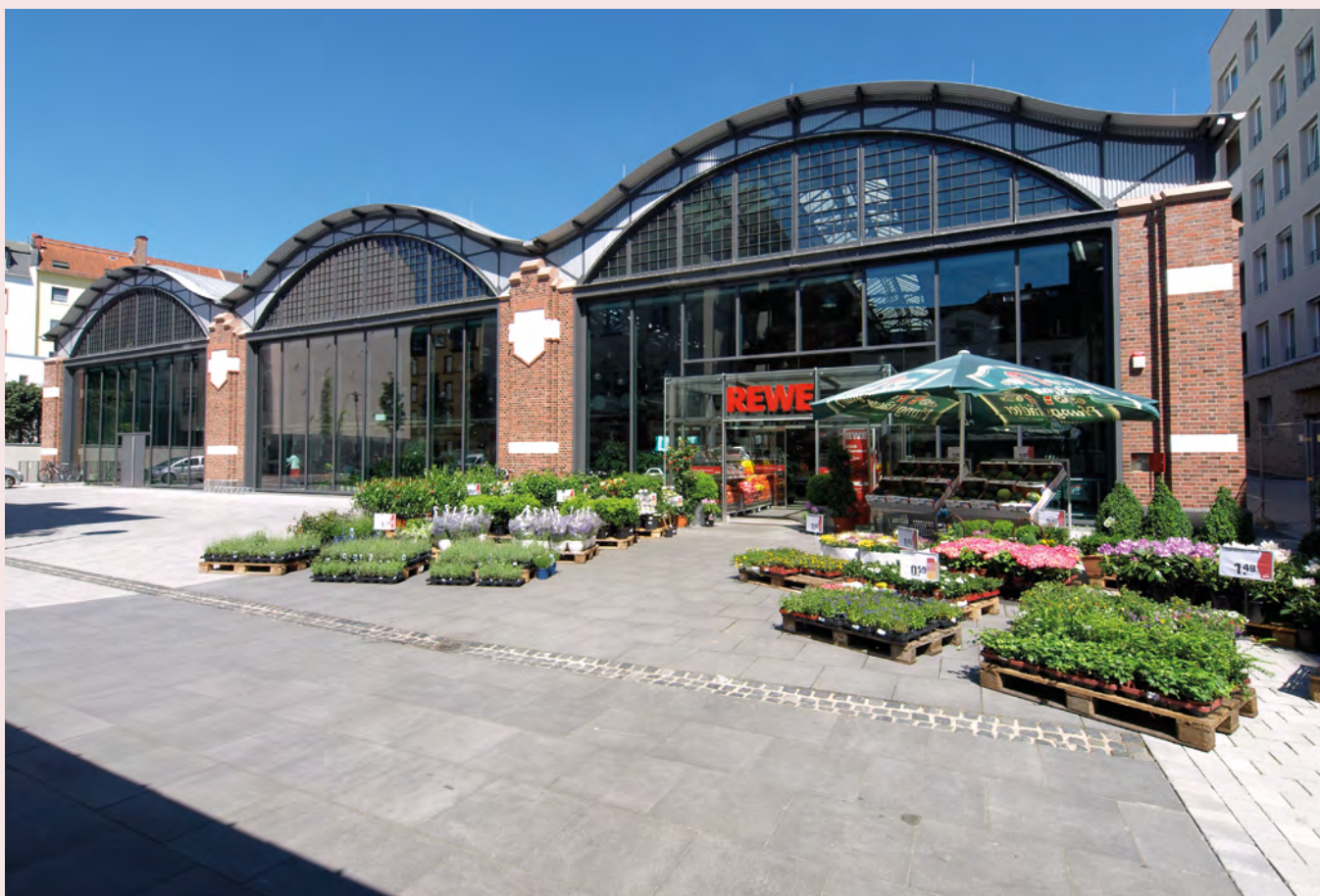
REWE-Supermarkt an der Heidestrasse in Frankfurt (Quelle: Lyson Architekten und Ingenieure)
