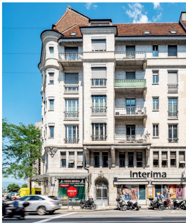
Zugang Liegenschaft an der Rue Francois Versonnex 11 in Genéve
