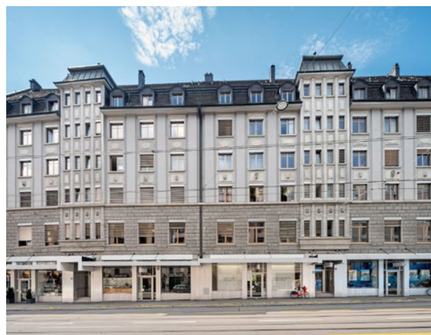
Zugang Liegenschaft an der Stampfenbachstrasse 57–59 in Zürich
